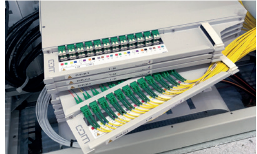
Oben: Kabelendverschluss in LWL-Knotenpunkt Unten: Kassetten für LWL-Steckverbindungen
