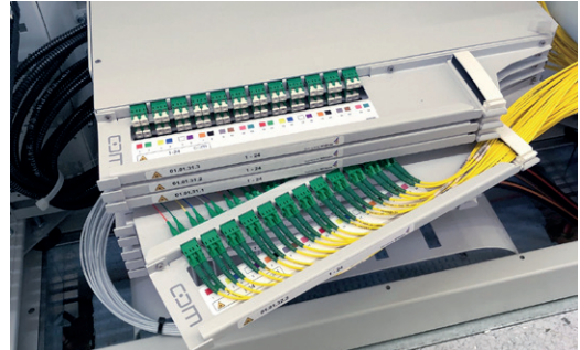
En haut: terminaison de câble dans le nœud FO En bas: cassettes pour connecteurs FO
